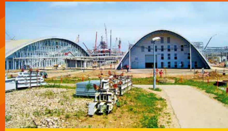
Щиты НКУ «АЭЛИТА» установлены на заводе ООО «РусВинил» (Нижегородская область).
